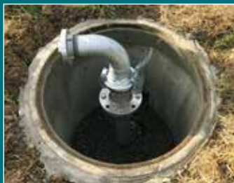
Auslaufbogen mit Storzanschluss
